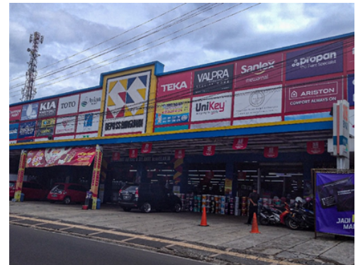
Depo SS, Tasikmalaya
